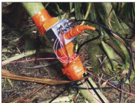
Einspeisung der Beverage-On-Ground-Antenne
